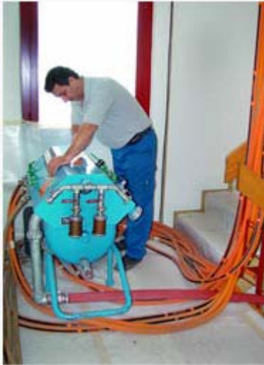
Kuva 5: Kolmas työvaihe, putkiston pinnoitus (Poxytec Oy [verkkodokumentti, viitattu 8.1.2006]).
