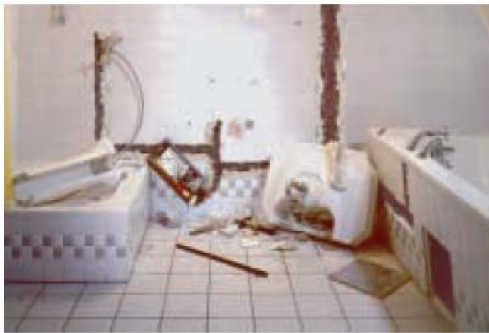
Kuva 1: Perinteinen täydellinen putkistoremontti (Poxytex Oy [verkkodokumentti, viitattu 8.1.2006]).
