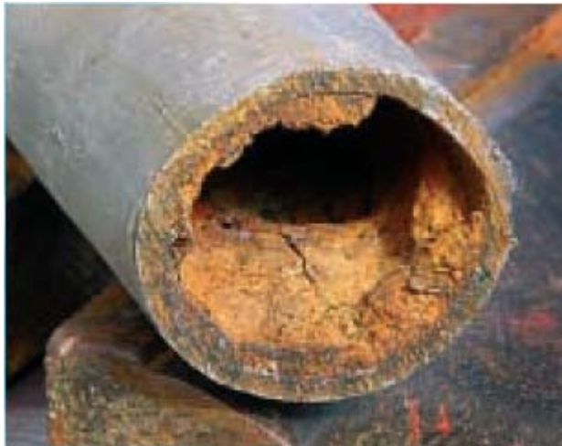
Kuva 2: Vanhan vesijohtoputken sisäpinta (Poxytec Oy [verkkodokumentti, viitattu 8.1.2006]).
