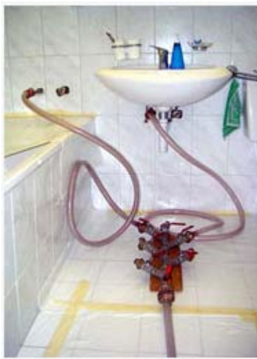
Kuva 3: Ensimmäinen työvaihe, putkiston kuivaus (Poxytec Oy [verkkodokumentti, viitattu 8.1.2006]).
