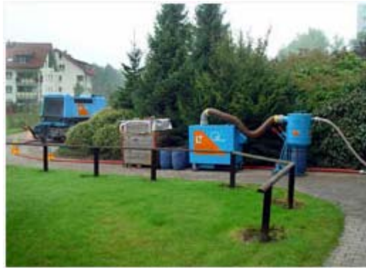
Kuva 4: Toinen työvaihe, putkiston puhdistus (Poxytec Oy [verkkodokumentti, viitattu 8.1.2006]).
